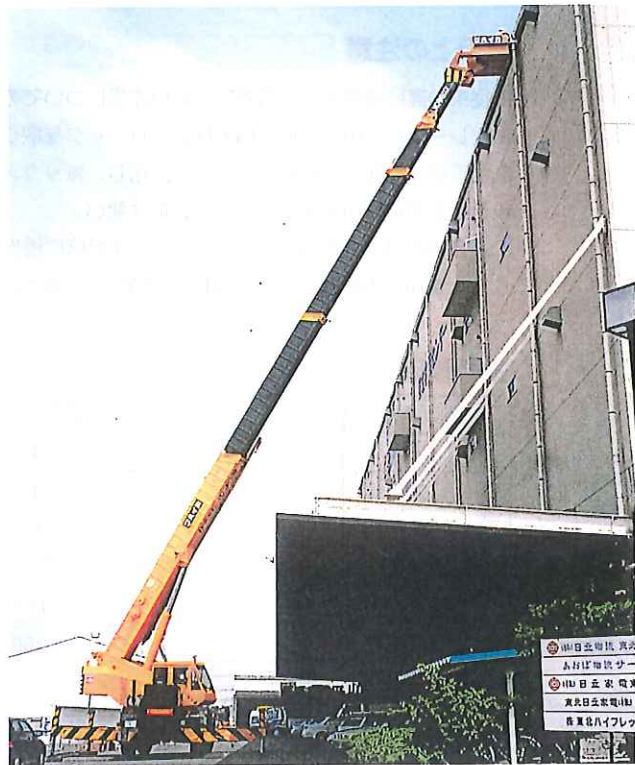
倉庫 補修工事 (45tラフター)
