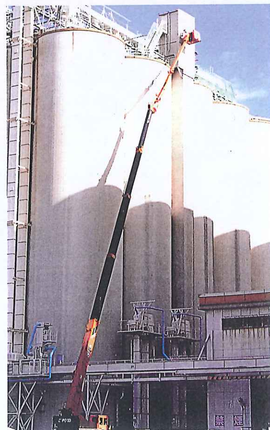
サイロ 壁面補修工事 (45tラフター)
