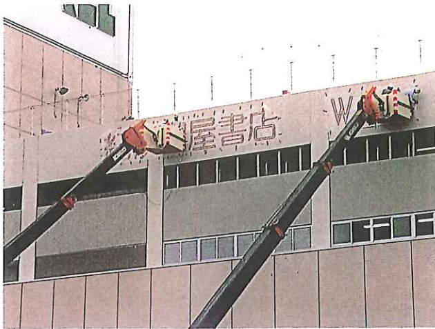
ショッピングセンター 看板取付工事 (25tラフター)
