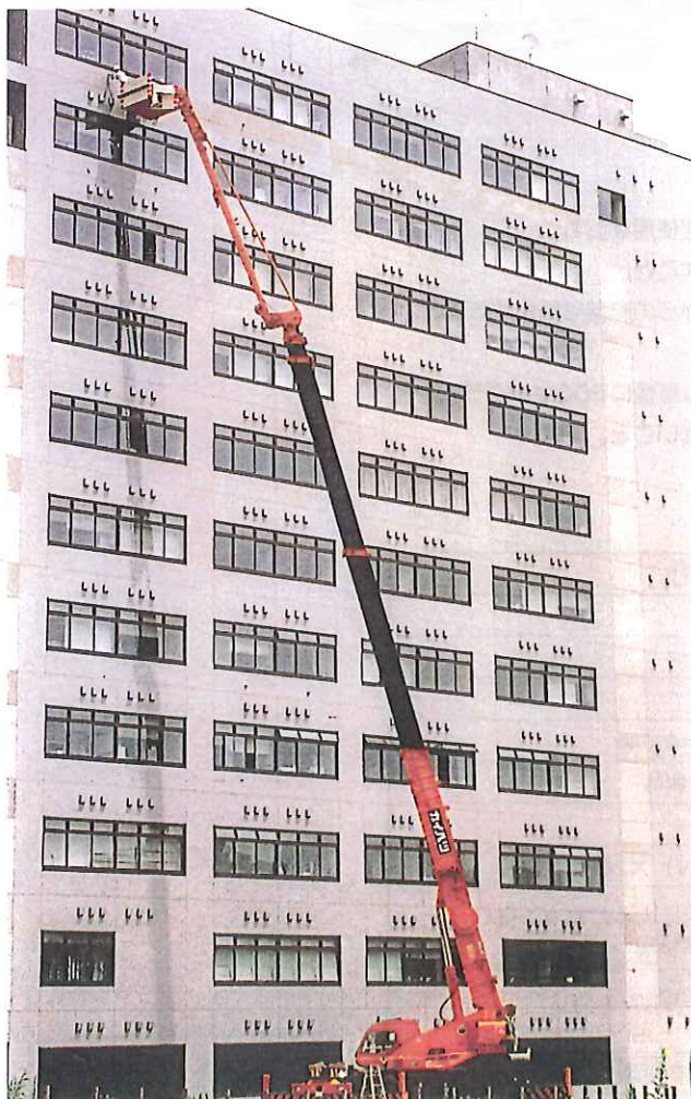
壁面点検作業 (45tラフター)
