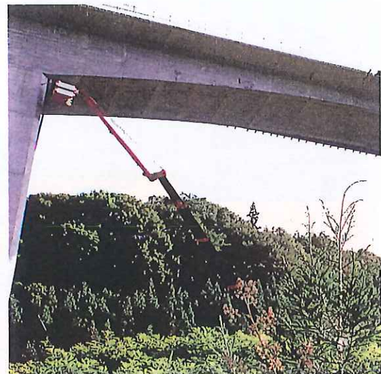
高速道 雨樋取付工事 (45tラフター)
