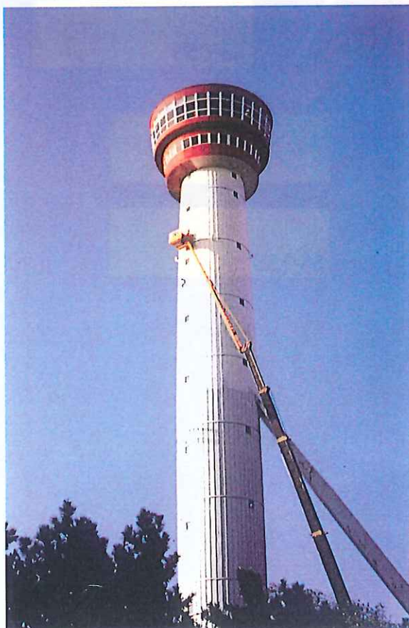
展望タワー 塗装作業 (45tラフター)
